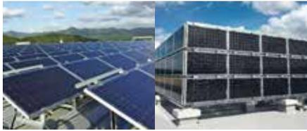
太陽光発電(屋上設置だけでなく、日隠し壁として垂直にも設置)
