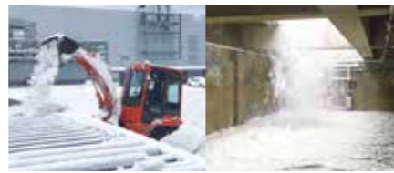
駐車場に設置したアーケードおよび融雪装置
