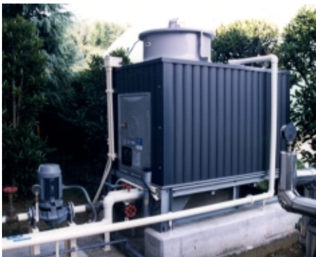
焼成炉の冷却水循環装置(成田工場)
