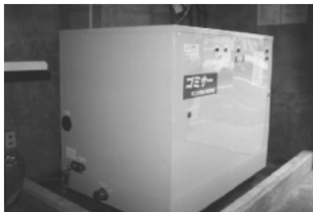
千曲川工場 厨房処理施設
