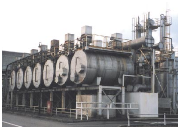
有機溶剤のリサイクルプラント(三隈川工場)
