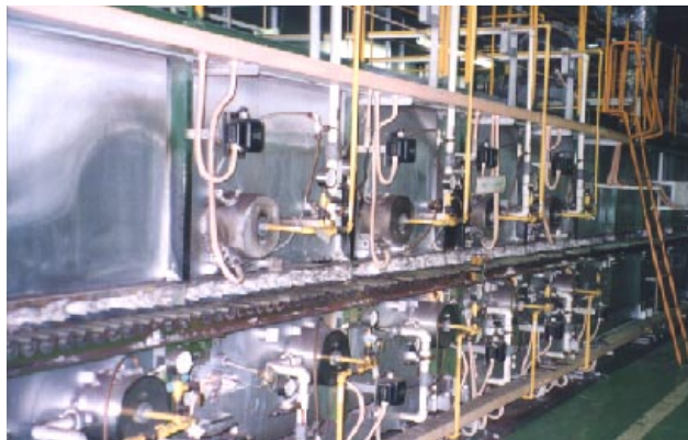
LPGを利用した焼成炉(静岡工場)
