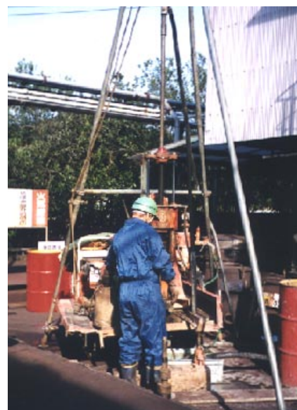
ボーリング調査
