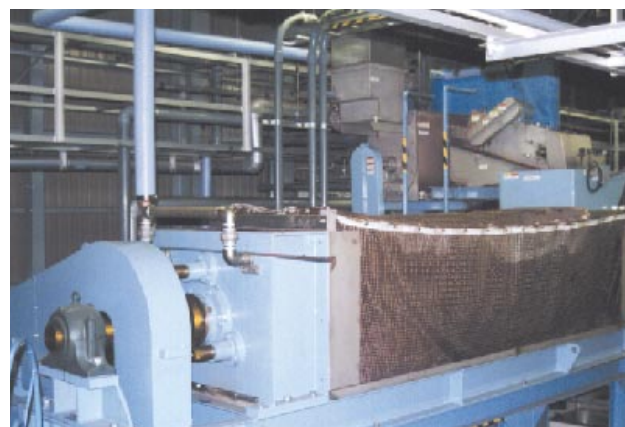
汚泥減容化のための脱水機(稲倉工場)
