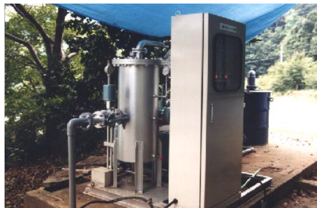
浄化対策(土壌ガス吸引浄化法)
