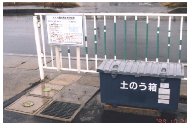
駐車場に設置した油水分離装置(象潟工場)
