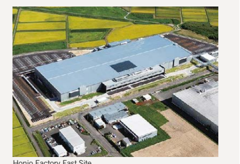
Honjo Factory East Site
